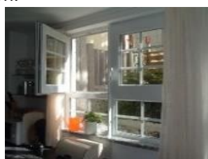
Hybridfenster mit Sprossen (Drehkipplügel oben, Festverglasung unten)
