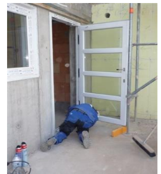
Oceanic Outside während dem Einbau
